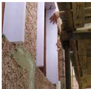
Osazení ostění otvorů polystyrénem
