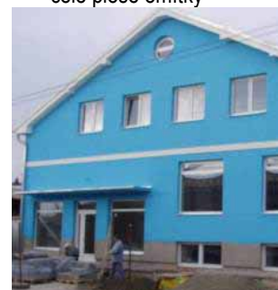
Finální úprava – nanesená Silikátová omítka na vyrovnávací vrstvu opatřenou penetrací
