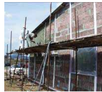
Na dřevostěpové materiály tepelně izolační omítku naneste přímo na podklad (bez cementového postřiku).
