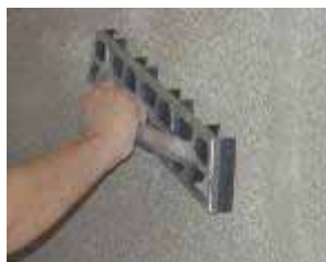
Zdrsněte povrch omítky škrabkou (celoplošně)
