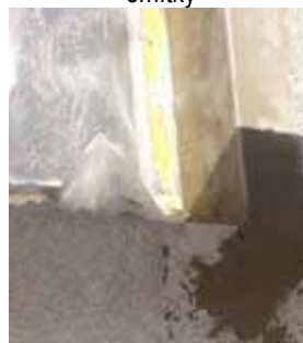
Do rohu otvorů vkládejte síťovinu a na ostění vkládejte rohové lišty se síťovinou
