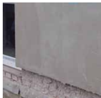
Vyrovnávací vrstvu přeburste a penetrujte pro nanesení štukové vrstvy (viz Alternativa Ib) nebo šlechtěné omítky (viz Alternativa IIb)
