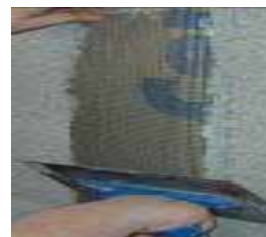
V místech přechodů vložte síťovinu
