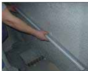
Zdrsněte povrch omítky latí (celoplošně)
