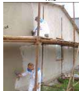
Po vložení síťoviny a osazení rohových profilů v jednom kroku proveďte vyrovnávací vrstvu po celé ploše omítky
