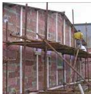
Stavba se ztracenými omítníky
