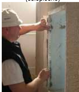
Rohy ostění před stěrkováním zpevněte
