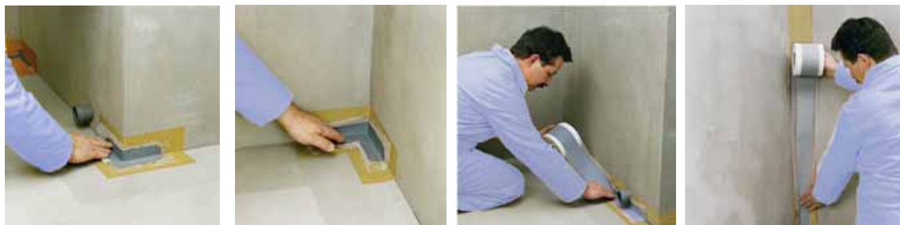
Vkládání pružné těsnicí pásky do první vrstvy Cemix Koupelnové hydroizolace
