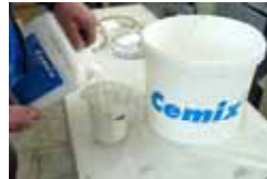
zušlechťující disperze : voda (1 : 1) záměsový roztok činí 50% hmotnosti omítky
