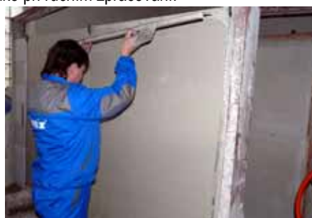
První stahování H profilem, oprava a zarovnání povrchu a měření síly omítky
