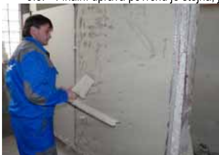
První stahování H profilem, oprava a zarovnání povrchu a měření síly omítky
