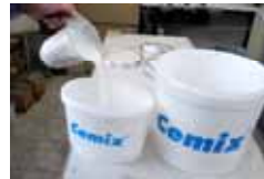
zušlechťující disperze : voda (1 : 1) záměsový roztok činí 50% hmotnosti omítky
