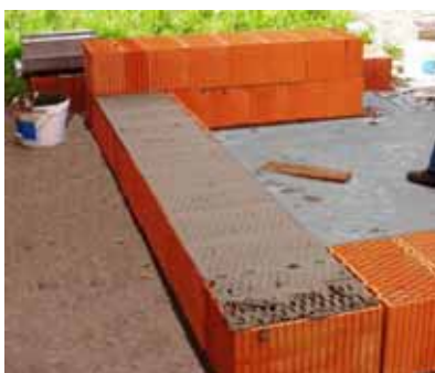
Celoplošně nanesená malta
