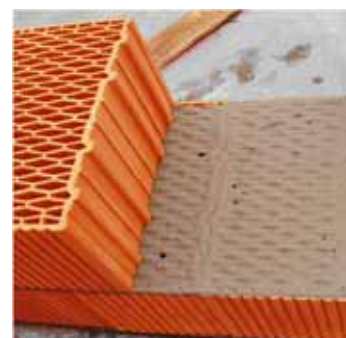
Kladení další vrstvy bloků
