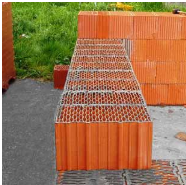
Pokládání tvarovek (tvarovky musí být položeny do 10 minut)
