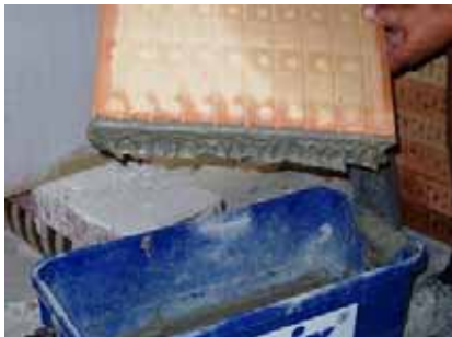
Namáčení tvarovky do malty (max.5 mm)
