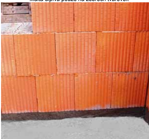
Po zavadnutí se základací malta seřízne do roviny
