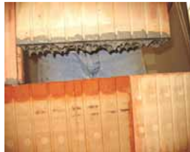
Osazování tvarovky do příčky (přesah min.10 cm)
