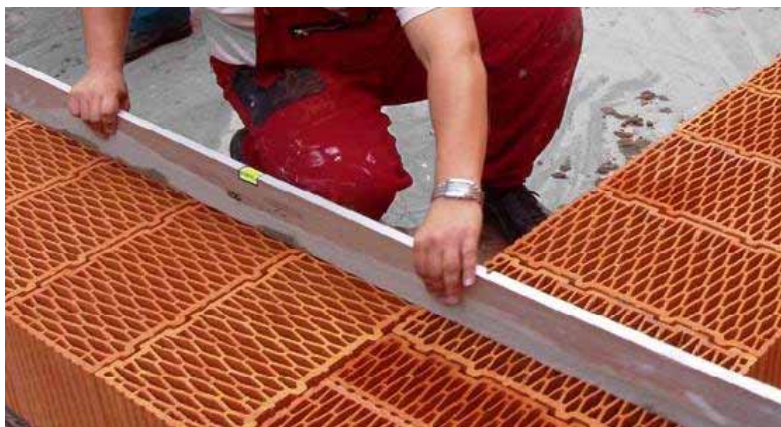
Kontrola a srovnání povrchu první řady
