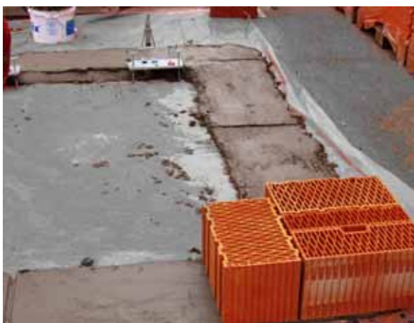
Skladba cihelných tvarovek na rohu
