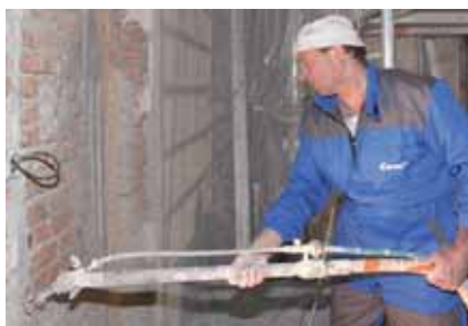
Strojní nanášení omítky
