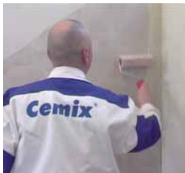
Nanášení nátěru Cemix Kontakt
