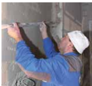
Stahování omítky latí
