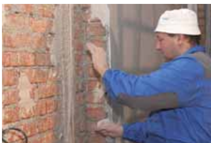
Příprava omítníků a rohů
