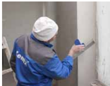
Úprava špalety po výměně okna
