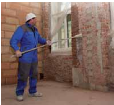
Nanášení nátěru Cemix Penetrace ASN
