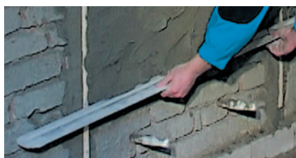
Nanesení jádrové omítky
