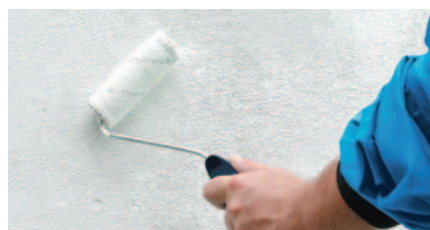
Provedení povrchové úpravy
