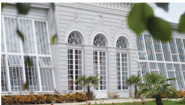
Odvlhčovací omítkový systém SUPERSAN zámecký skleník, Telč
