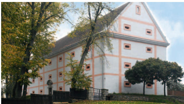
Sanační systém (s omítkami WTA) sýpka, Žirovnice
