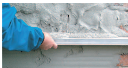
Nanesení podkladní a vyrovnávací omítky
