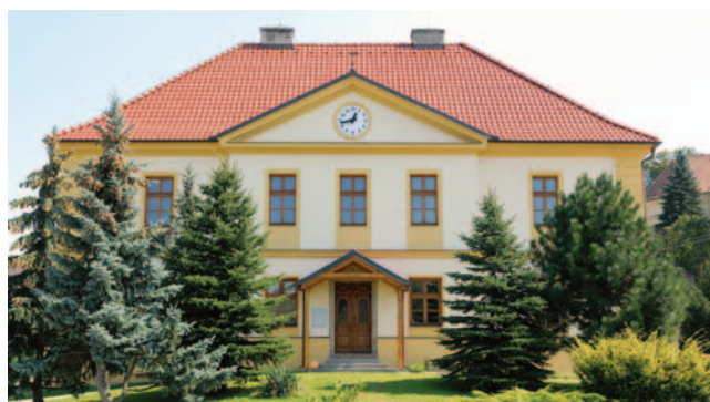
Sanační omítky WTA, Sanační omítky štukové fara Bílovice
