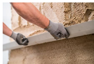
Obr. 7 Stahování omítky latí
