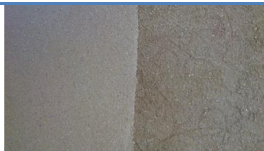
Obr. 9 Jemná omítka na jádrové omítce
