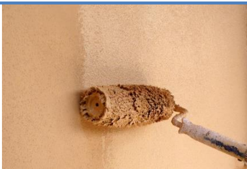
Obr. 10 Provádění nátěru
