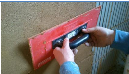
Obr. 8 Natahování omítky hladítkem
