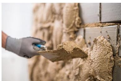
Obr. 5 Ruční nanášení omítky
