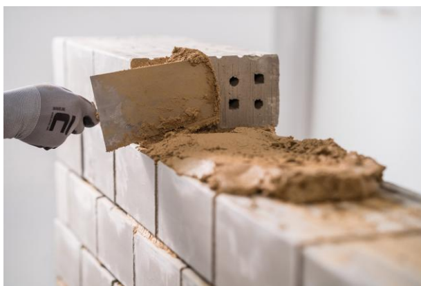
Obr. 2 Promaltování vodorovných i svislých spár
