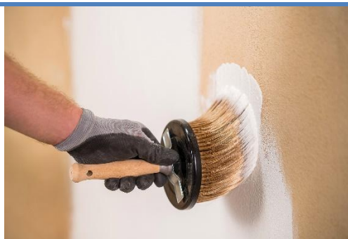
Obr. 11 Provádění nátěru
