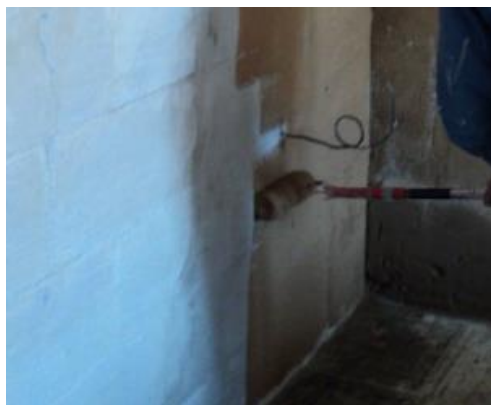
Obr. 3 Nanášení spojovacího můstku válečkem
