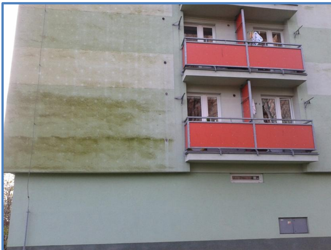
Obr. 1: Příklad výskytu biotického porostu na zateplené fasádě
