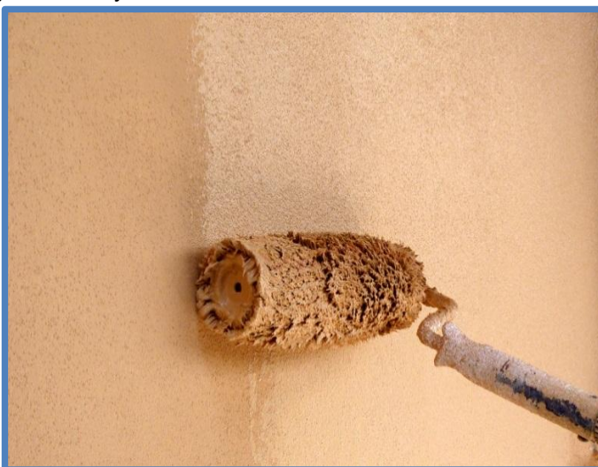
Obr. 3 - Provádění fasádního nátěru
