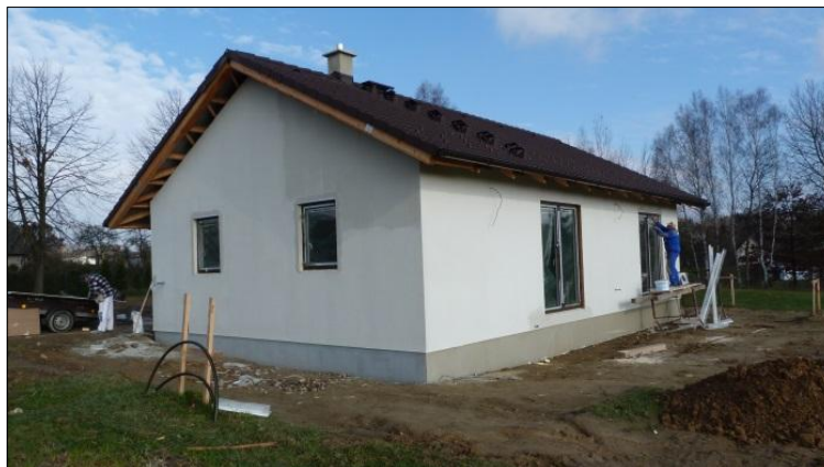
Obr. 4: Objekt opatřený základní vrstvou
