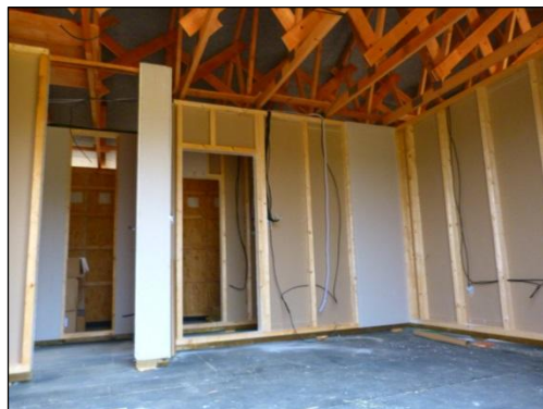
Obr. 3 Vnitřní konstrukce dřevostavby
