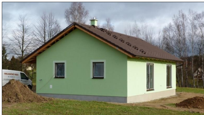
Obr. 7: Hotová fasáda objektu
