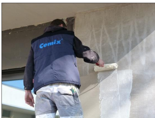
Obr. 5: Provádění penetračního nátěru omítky
