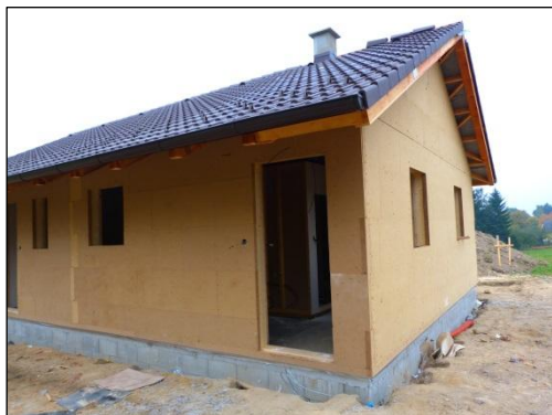
Obr. 2: Příklad opláštění dřevostavby dřevovláknitými deskami
