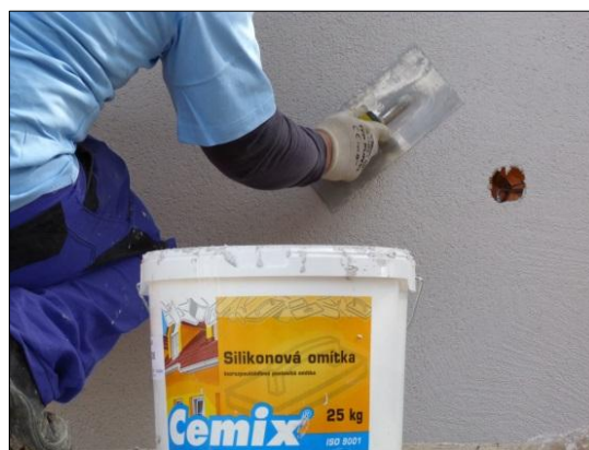
Obr. 6: Natahování strukturální omítky
