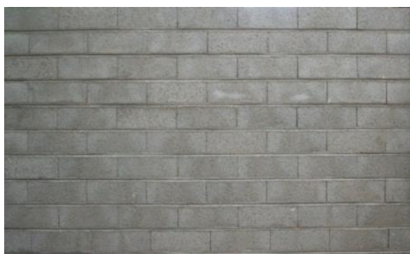
Obr. 1 – Zdivo z betonových skořepinových tvárníc
