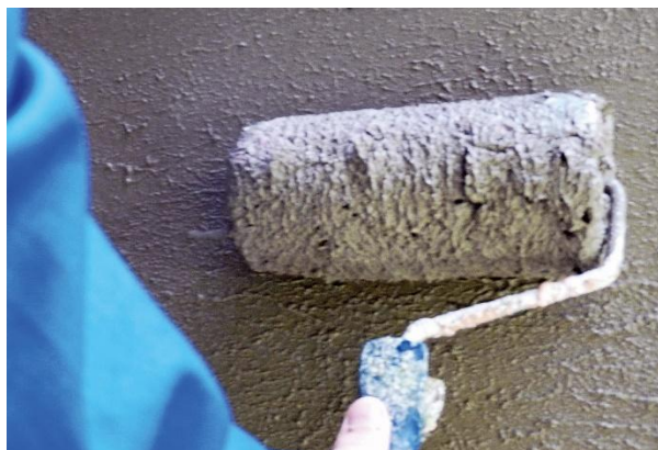
Obr. 2 Nanášení polymercementového můstku
