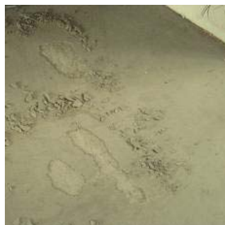
Silnější krusty je nutné odstranit přebroušením
