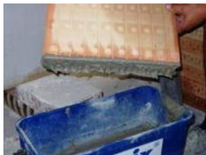
Namáčení tvarovky do malty (max. 5 mm)
