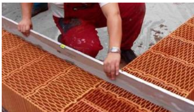
Kontrola a srovnání povrchu první řady
