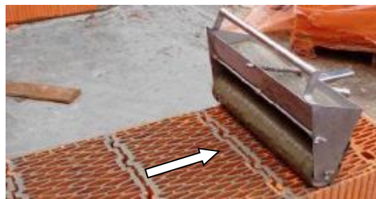
Nastavením optimální štěrby a pohybem válce dopředu se hmota nanáší na blok
