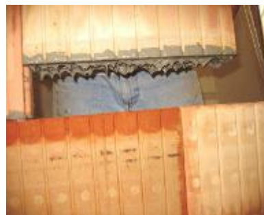
Osazování tvarovky do příčky (přesah min. 100 mm)
