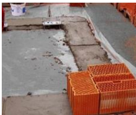
Skladba cihelných tvarovek na rohu
