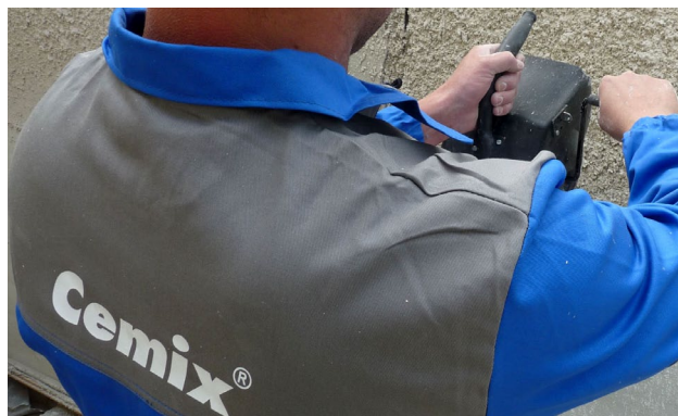
Aplikace ručním stříkáním / vytváření stříkané struktury
