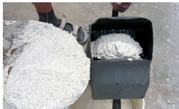
Plnění omítacího mlýnku
