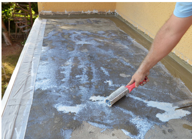
Penetrace podkladu
