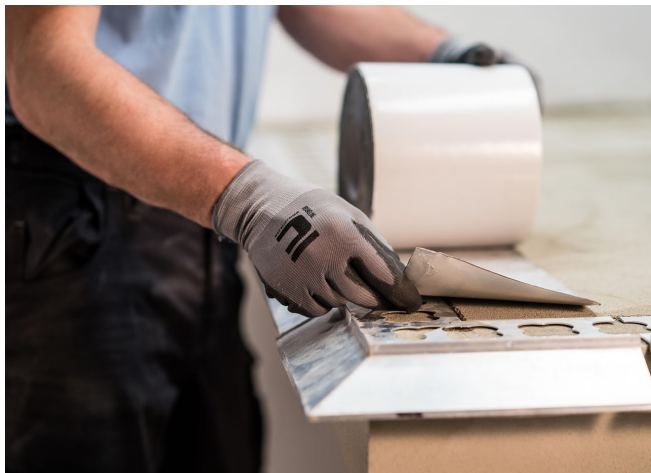
Uchycení plechu samolepicím butylovým pásem 8101 AQUASTOP TAPE FIX
