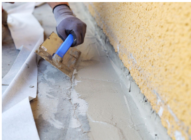
První vrstva hydroizolace připravená pro vložení pružné těsnicí pásky
