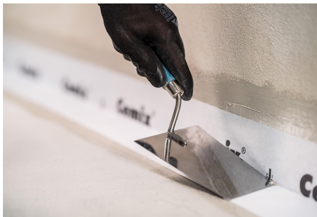
Pružná těsnicí páska v první vrstvě hydroizolace
