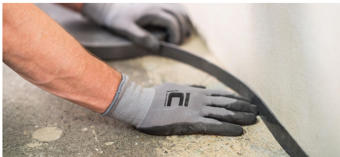
Umístění dilatační pásky 5903 SAMOLEPICÍ DILATAČNÍ PÁSKA 3/30
