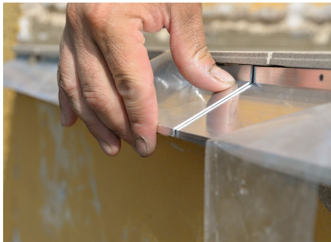
Opatření spojkou profilu
