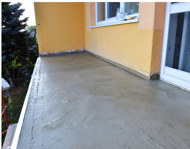
Hydroizolace ve dvou vrstvách nátěru
