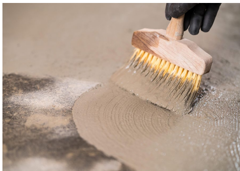
Aplikace kontaktního můstku 5050 KONTAKT ZE
