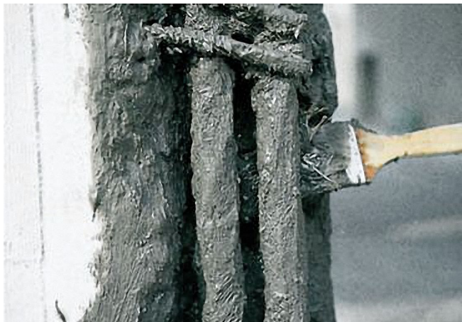
Aplikace antikorozní ochrany výztuže 1515 KONTAKT CT
