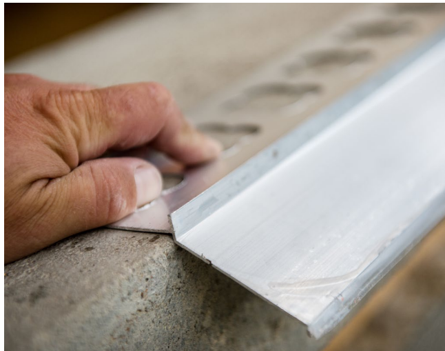
Provizorní usazení profilu
