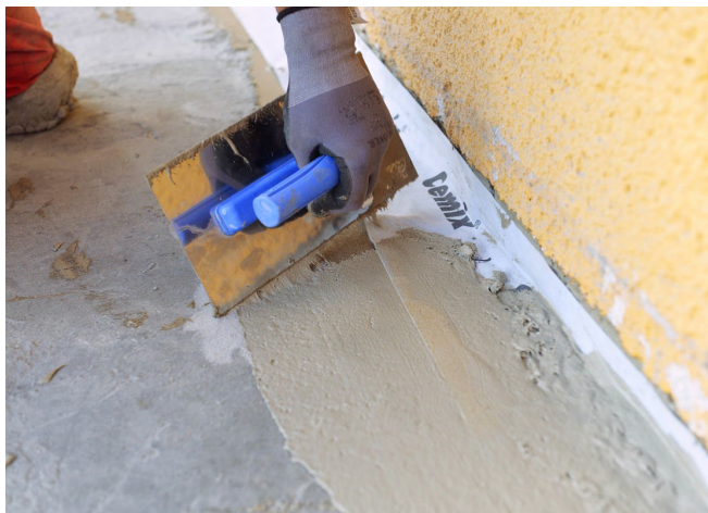
Aplikace druhé vrstvy hydroizolační stěrky
