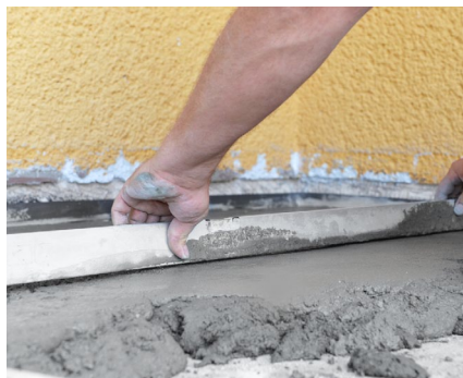
Vytváření spádového klínu
