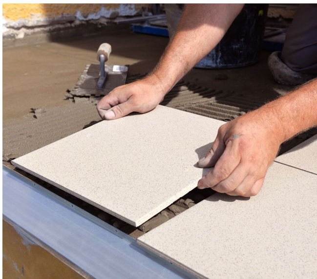
Lepení dlažby od okraje balkonu
