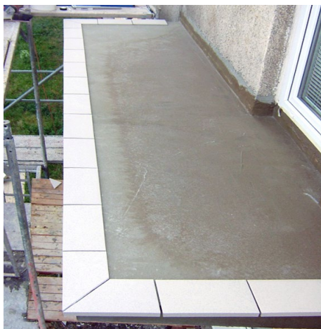
Osazení keramické tvarovky
