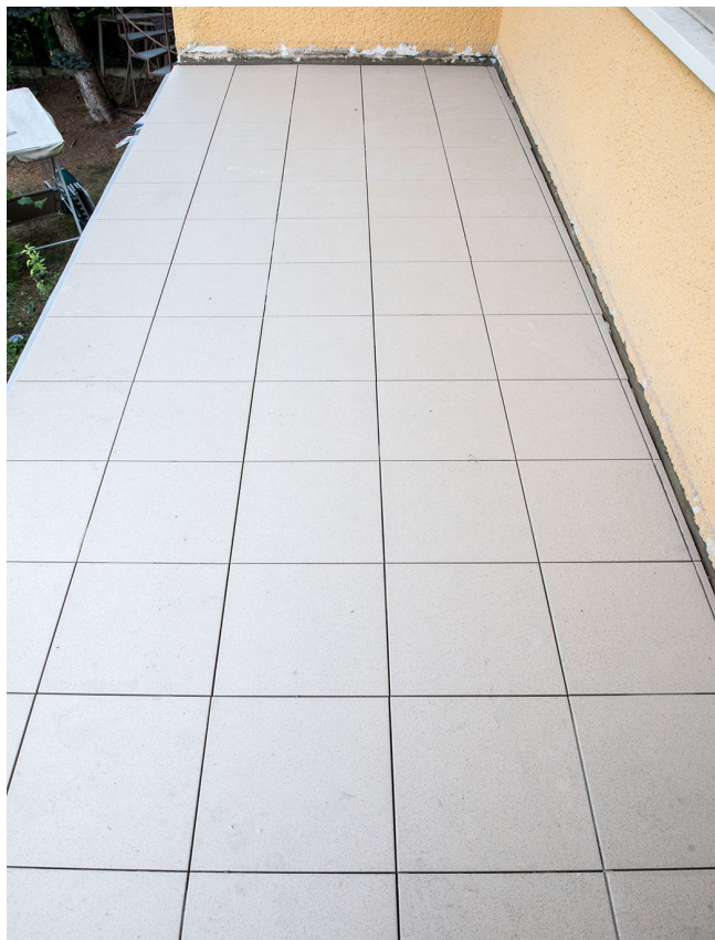
Hotový vyspávaný povrch
