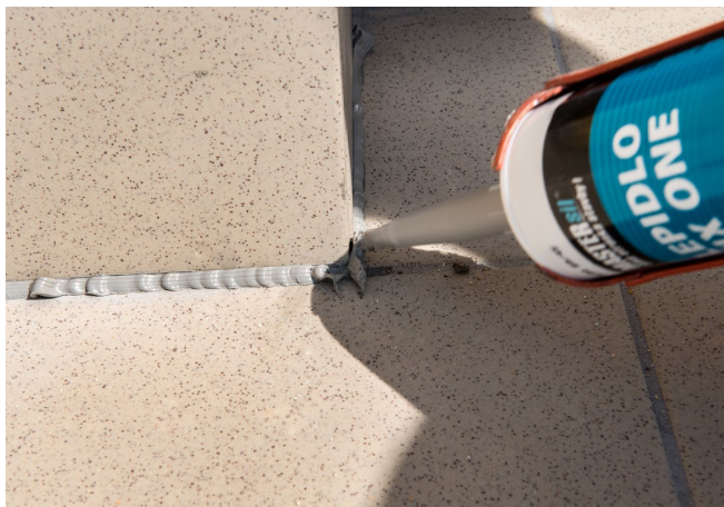
Tmelení styku stěna podlaha
