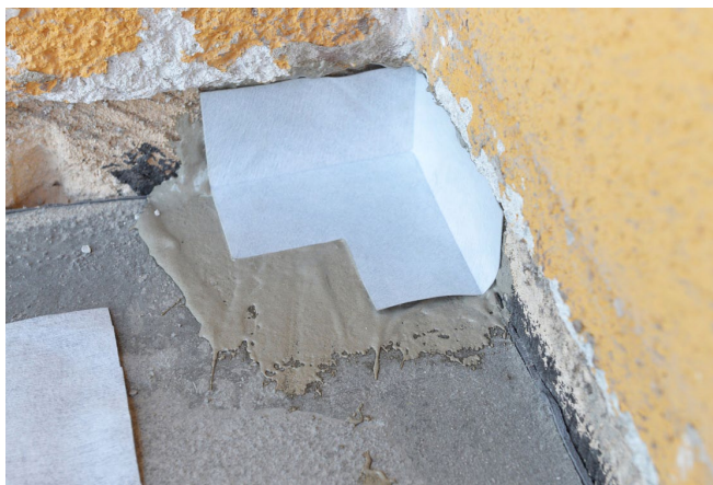
Použití do rohu 8103 pro dokonalou vodotěsnost koutového spoje
