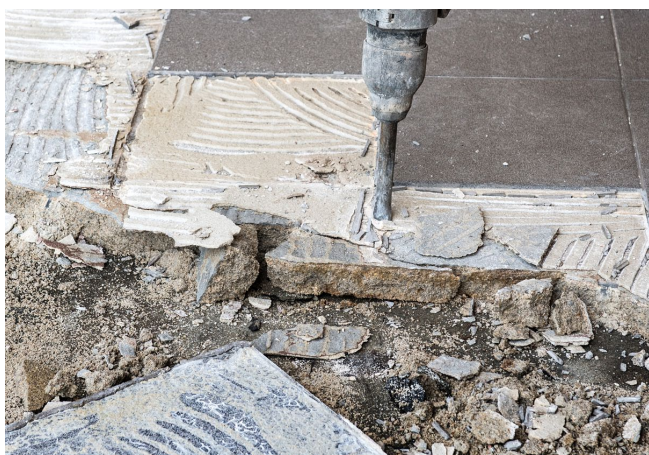
Odstranění uvolněných částí povrchu balkonů
