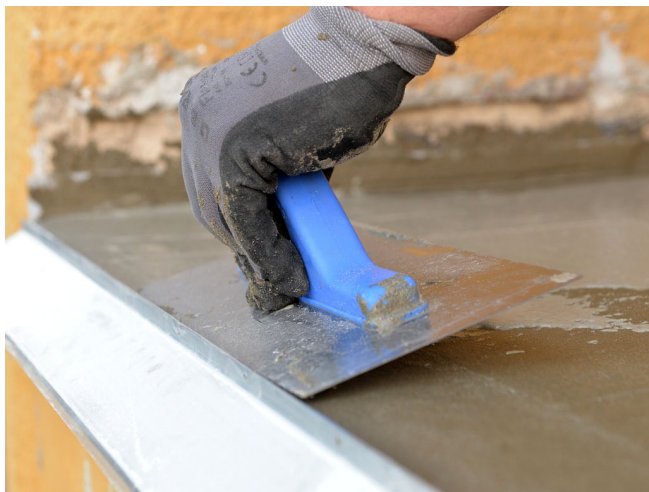
Dotážení hydroizolace až k hraně balkonového profilu
