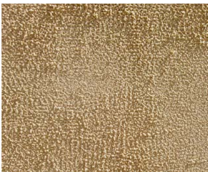
VÁLEČKOVÁNÍ JEŽKOVÝM VÁLCEM
