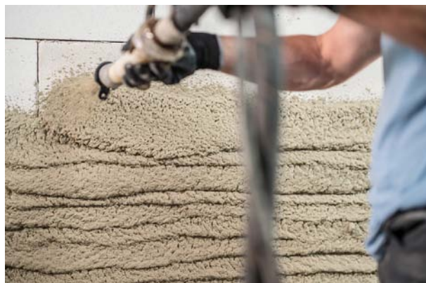
Strojní nanášení omítky
