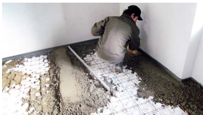
Provádění cementových potěrů
