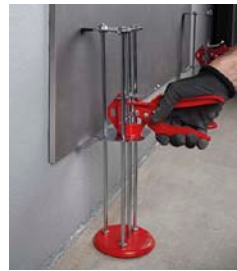
Aretace obkladu bez narušení podkladu – hydroizolační vrstvy
