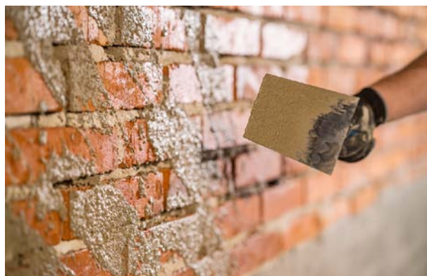
Provádění postřiku
