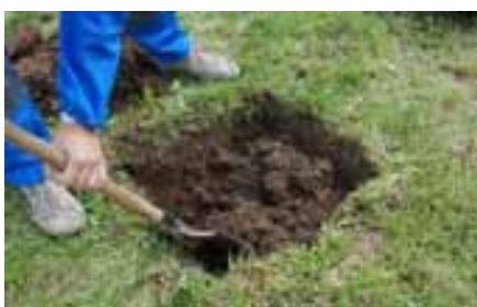
vykopeme jámu do hloubky 50 cm a zarovnáme dno
