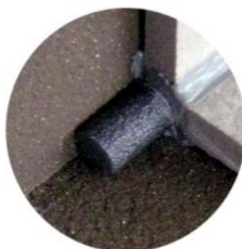
obr. 8 Detail umístění separačního provazce, který zabraňuje třibodovému uchycení tmelu. Volí se provazec o větším průměru než je šířka spáry pro její dokonalé vyplnění.
