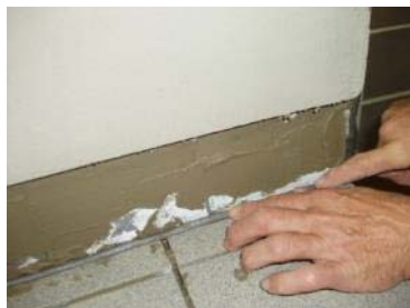
obr. 6 Detail umístění separačního provazce, který zabraňuje tříbodovému uchycení tmelu. Volí se provazec o větším průměru, než je šířka spáry pro její dokonalé vyplnění.
