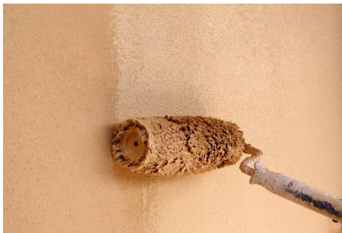
Obr. 3 - Provádění fasádního nátěru
