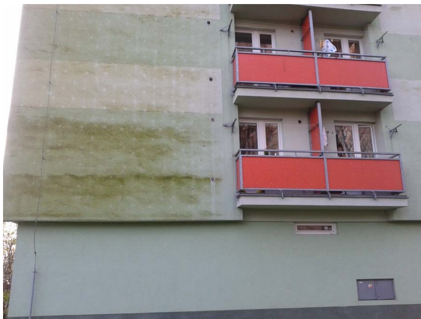
Obr. 1: Příklad výskytu biotického porostu na zateplené fasádě
