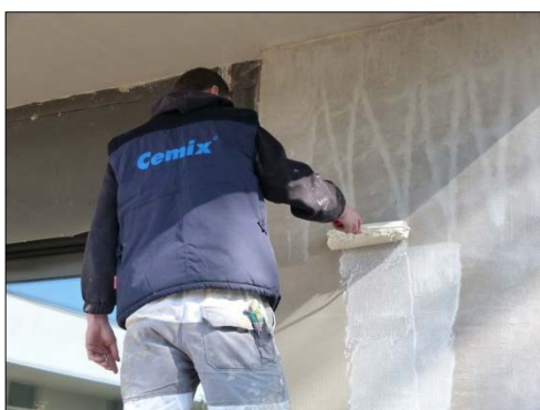
Obr. 5: Provádění penetračního nátěru omítky
