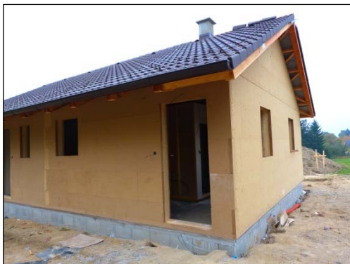
Obr. 2: Příklad opláštění dřevostavby dřevovláknitými deskami
