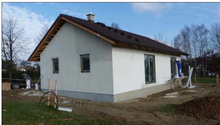
Obr. 4: Objekt opatřený základní vrstvou
