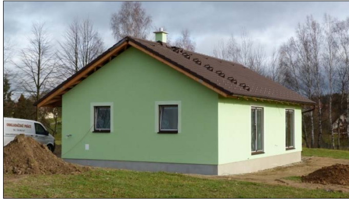
Obr. 7: Hotová fasáda objektu
