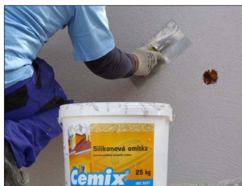
Obr. 6: Natahování strukturální
