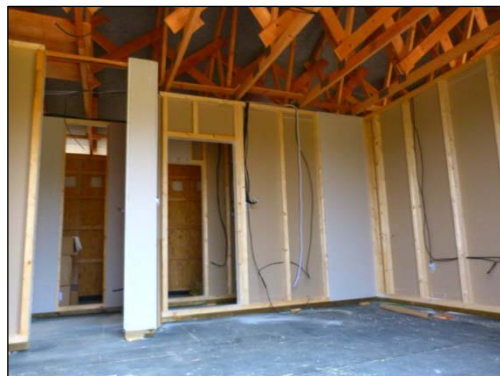
Obr. 3 Vnitřní konstrukce dřevostavby
