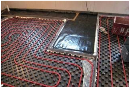
Podklad s fixovaným topným potrubím
