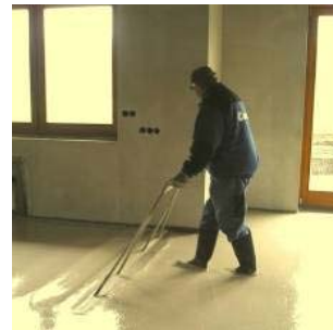
Zarovnání, odvzdušnění a homogenizace čerstvého potěru
