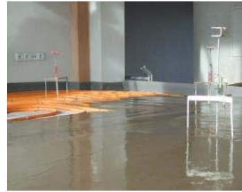
Strojní aplikace potěru na podlahové topení
