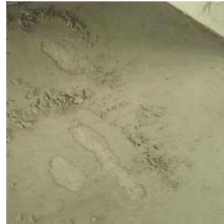
Silnější krusty je nutné odstranit přebroušením
