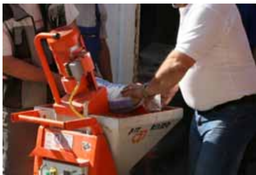
Obrázek 5: Vsyávání suché maltové směsi do zásobníku
