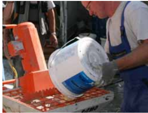
Obrázek 2: Plnění zásobníku pastovitou omítkou
