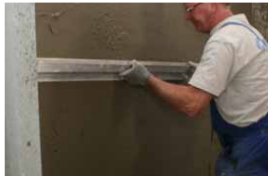
Obrázek 10: Finální zarovnání stěrkové vrstvy
