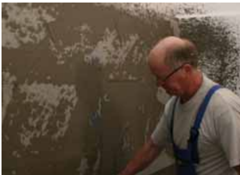
Obrázek 9: Zapracování síťoviny do stěrky
