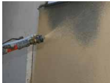
Obrázek 4: Stříkání omítky strojem PFT RITMO
