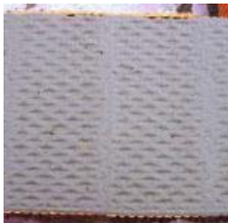
Detail maltového lože (malta nepropadá)
