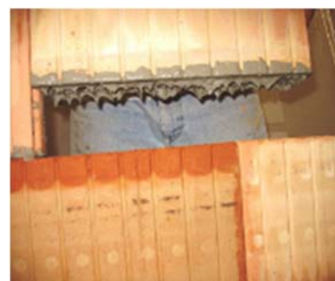
Osazování tvarovky do příčky (přesah min. 100 mm)
