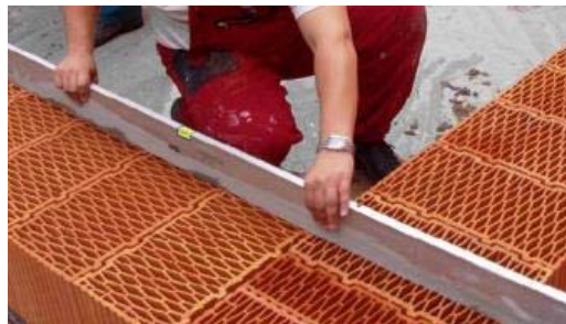
Kontrola a srovnání povrchu první řady
