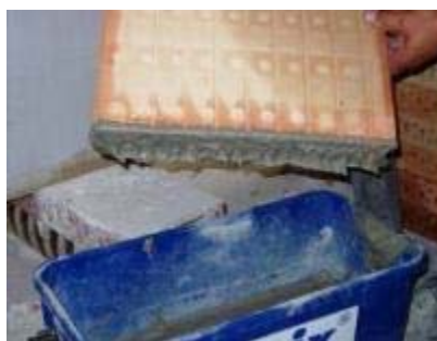
Namáčení tvarovky do malty (max. 5 mm)
