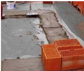
Skladba cihelných tvarovek na rohu
