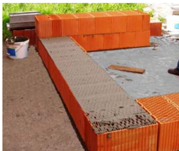
Celoplošně nanesená malta
