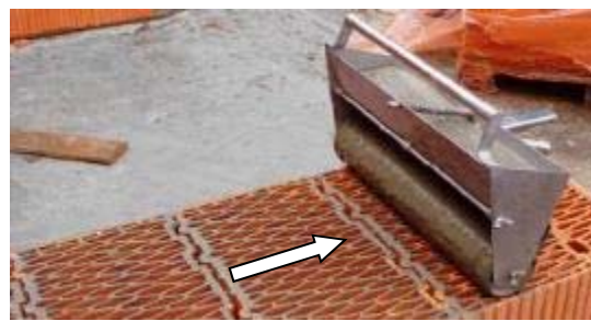
Nastavením optimální štěrbině a pohybem válečku dopředu se hmota nanáší na blok
