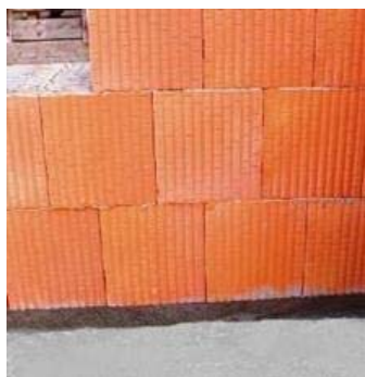
Po zavaznutí se základací malta seřízne do roviny
